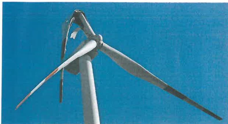
Solche Rotorblattschäden lassen sich durch Präventivwartung vermeiden.
